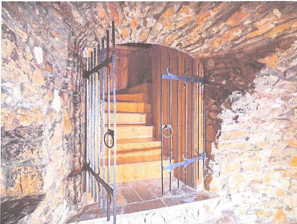
Rys. 3. Wejście do piwnicy – widok od strony piwnicy (źródło własne).
