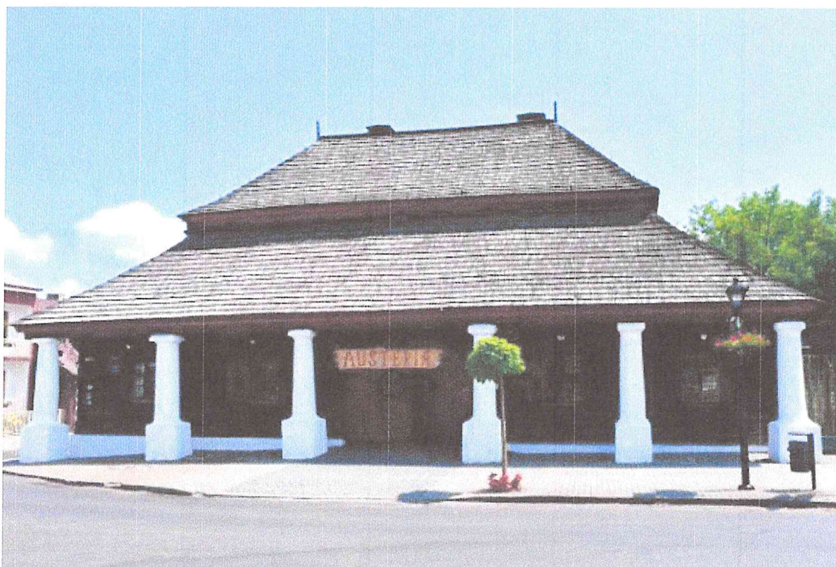
Rys. 1. Widok od frontu budynku (źródło własne).
