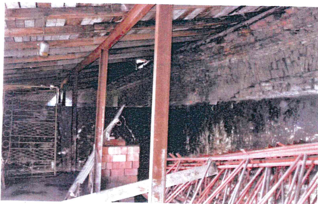
Rys. 12. Wnętrze dobudówki; widoczny fragment łuku nad zasypnym dawnym kanałem
