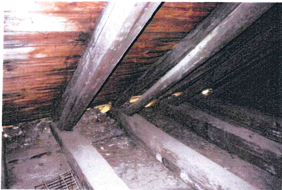
Rys. 18. Więźba z długimi przypustnicami sięgającymi poziomu jętek
