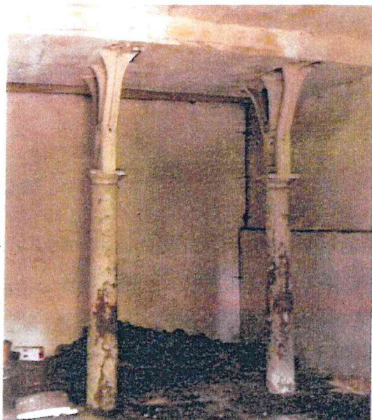
Rys. 13. Żeliwne słupy z głowicami pod podciąg ramy podłużnej
