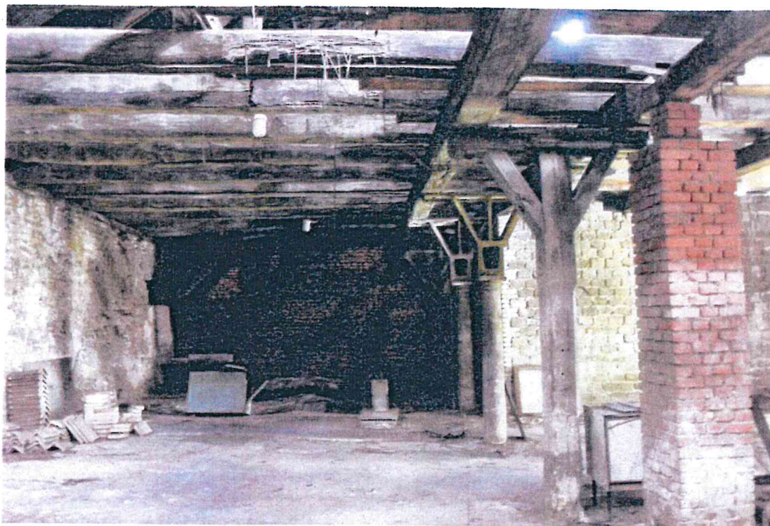
Fot. 11. Wnętrze części halowej (strona zachodnia); filary ramy podłużnej – żeliwne, drewniane i współczesne murowane
