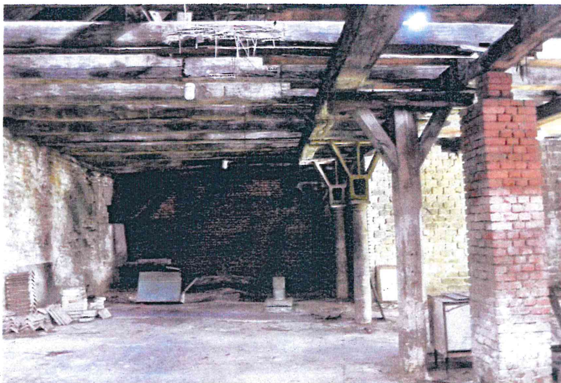
Rys. 4. Widok wnętrza w zachodniej części halowej
