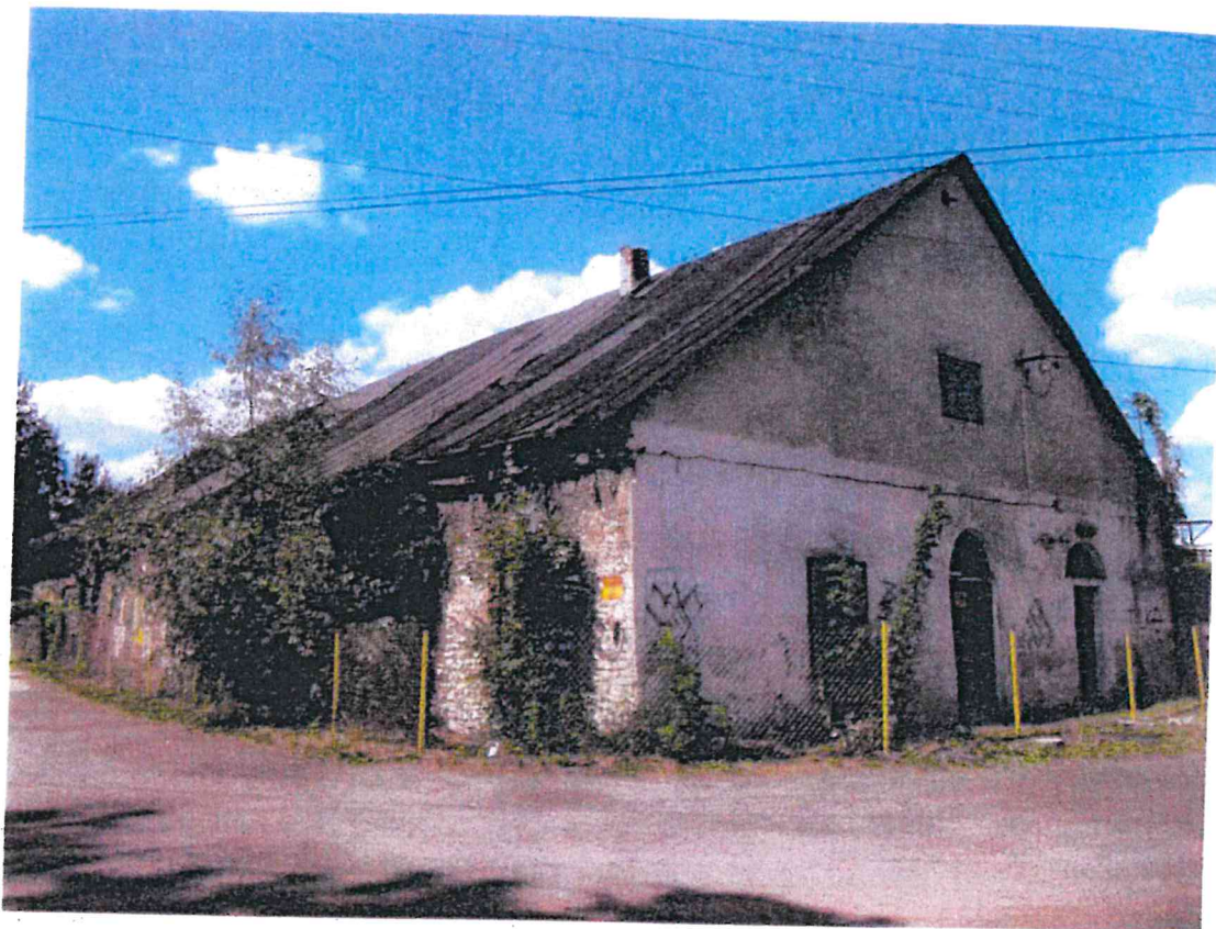
Fot. 1. Budynek walcowni, elewacja południowa i szczytowa wschodnia
