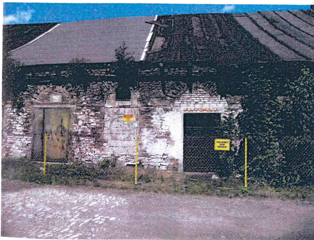
Fot. 4. Elewacja południowa, część środkowa; widoczny bruk nad dawnym kanałem
