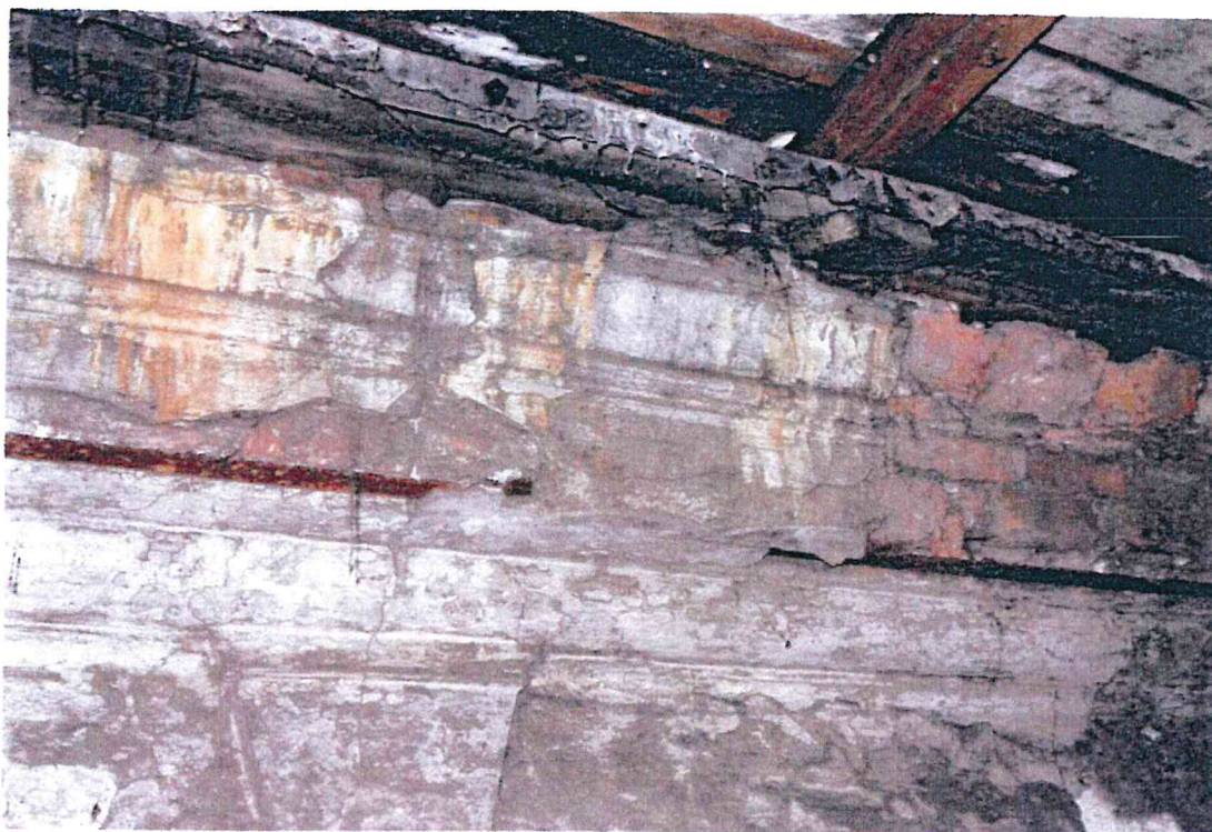
Rys. 20. Zachowane relikty tynków na obramieniach okiennych ze zwornikami i na gzymsie
