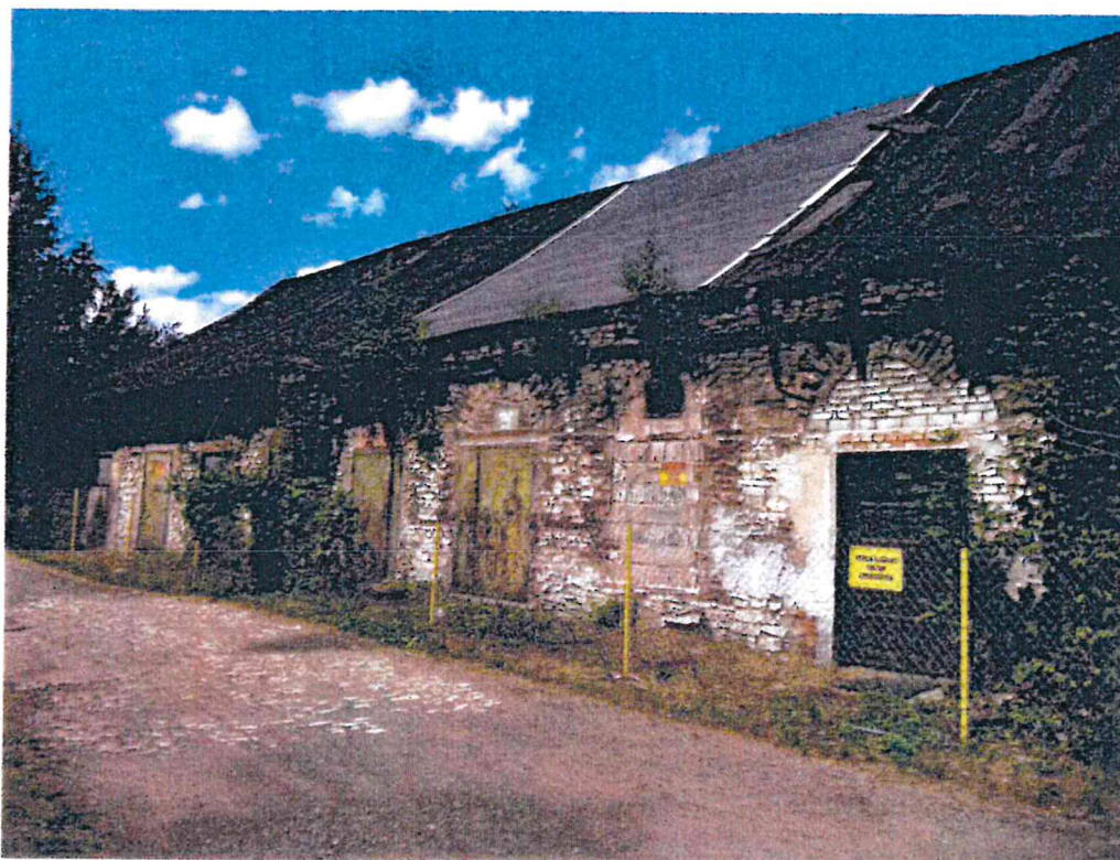
Rys. 7. Odcinek nawierzchni brukowej nad zasypnym kanałem
