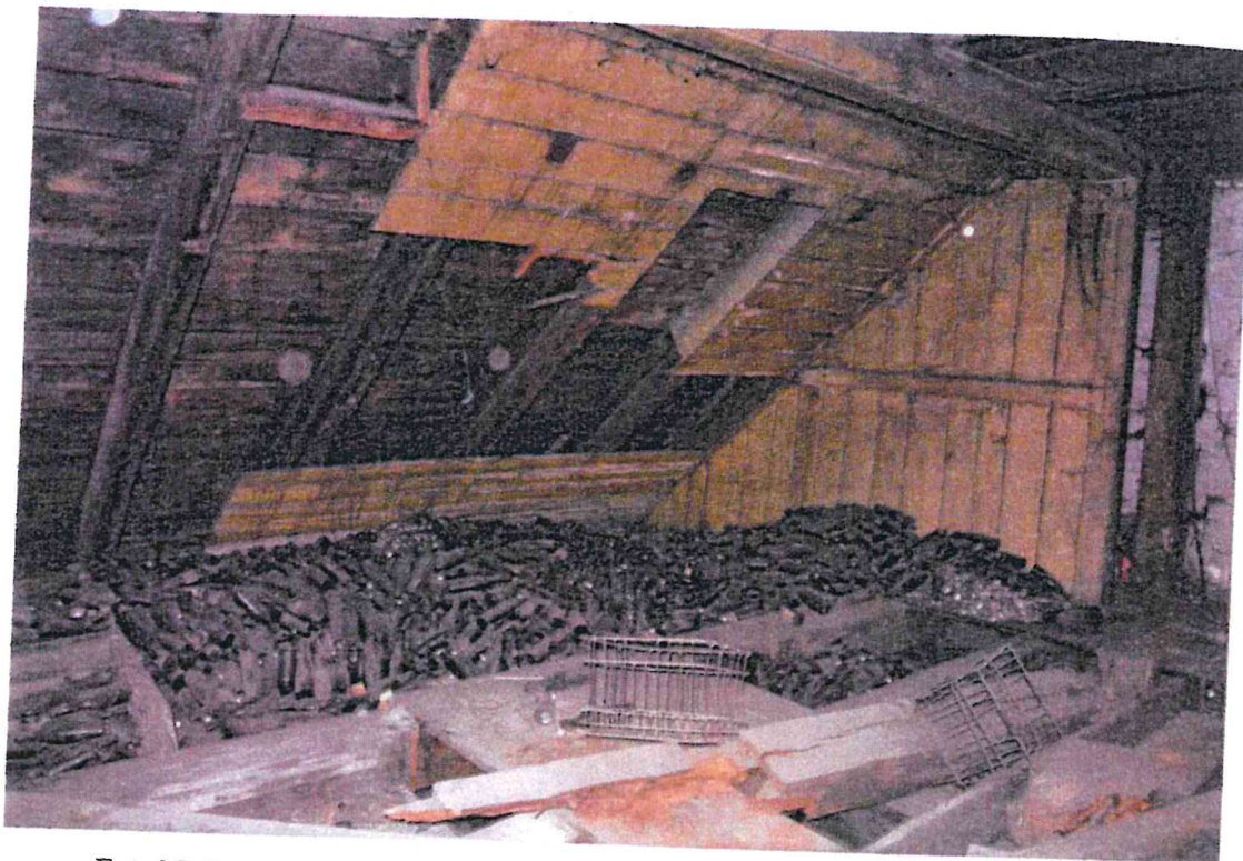
Fot. 27. Butelki na stropie nad byłą cukiernią; resztki dawnej zabudowy poddasza
