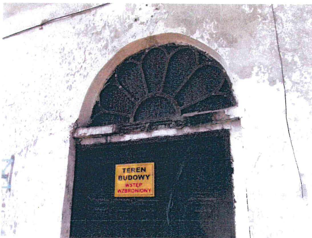
Rys. 21. Zachowana metalowa półrozeta w naświetlu drzwi na szczytowej elewacji wschodniej
