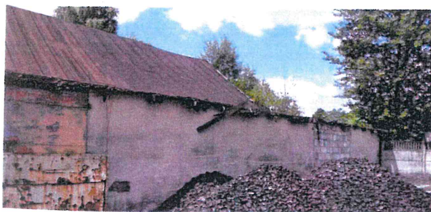
Rys. 11. Dobudówka – widok na ścianę północną
