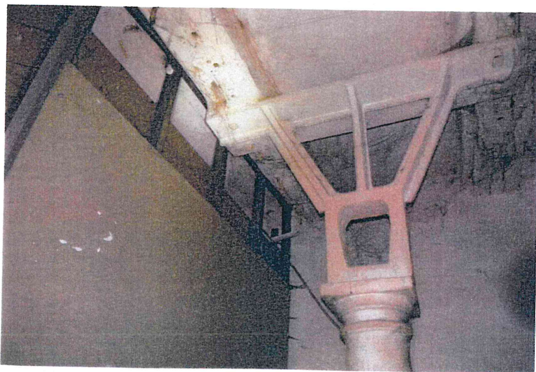
Fot. 30. Głowice żeliwnych słupów
