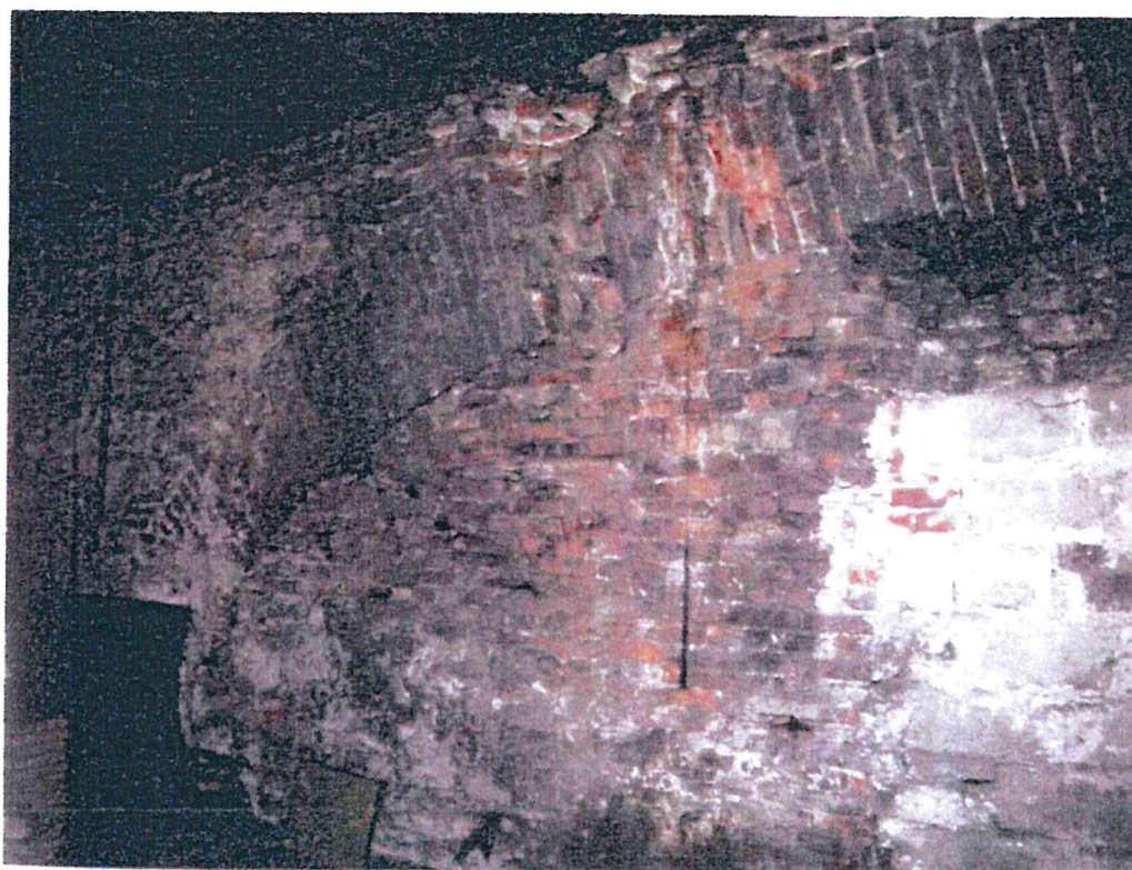
Rys. 8. Zamurowany łuk w ścianie północnej nad zasypnym kanałem
