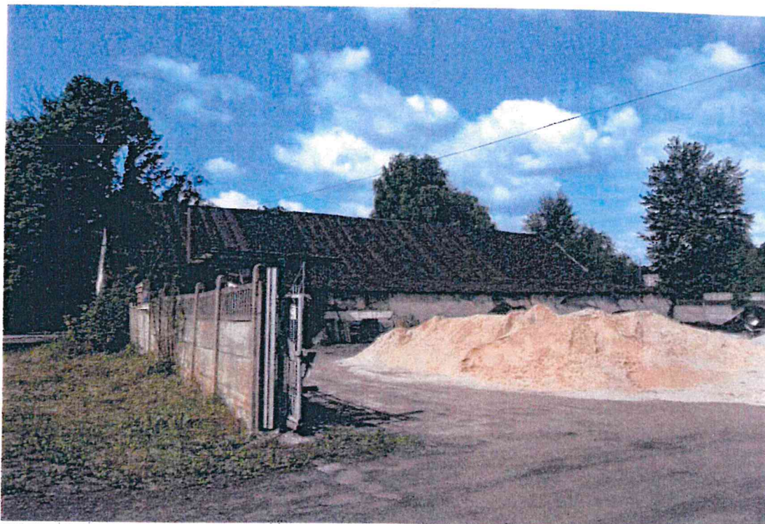
Fot. 3. Budynek walcowni, elewacja północna z dobudówką
