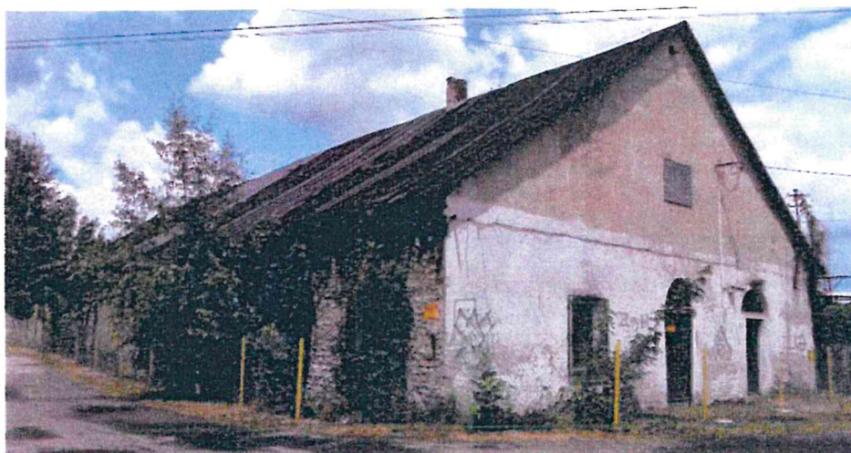
Rys. 2. Widok budynku walcowni (07. 2019 r.)
