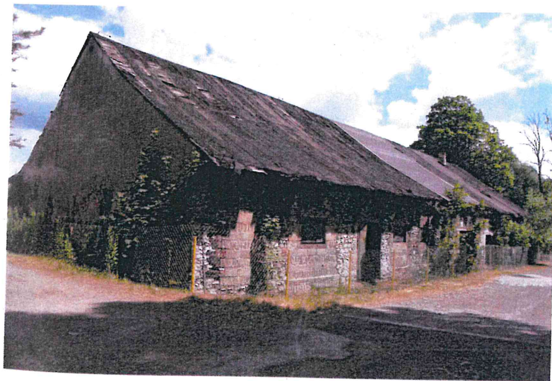
Fot. 2. Budynek walcowni, elewacja południowa i szczytowa zachodnia
