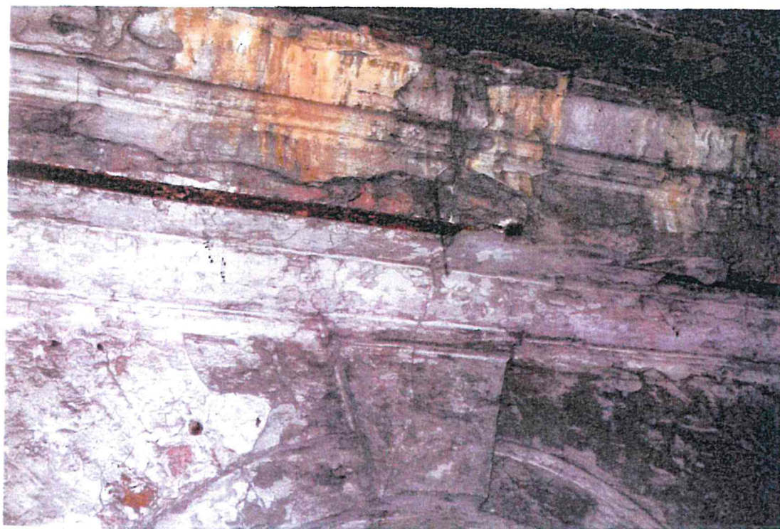
Rys. 19. Zachowane relikty tynków na obramieniach okiennych ze zwornikami i na gzymsie
